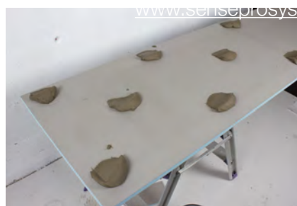
Fördela fästmassan i ett tärnings mönster.
