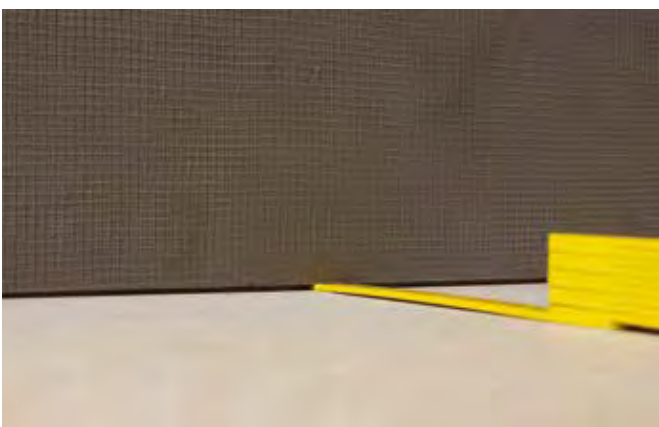
Montera med några mm. från golv och tak.
