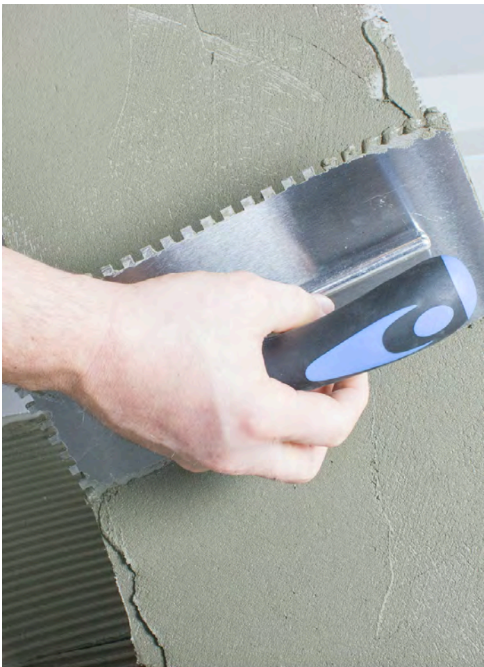
Påför fästmassan direkt på skivan.
