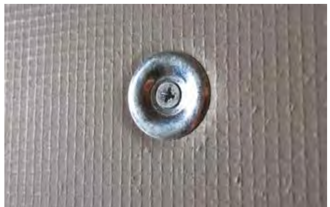
Monteringsbrickan får inte skapa en höjd eller för stor grop.
