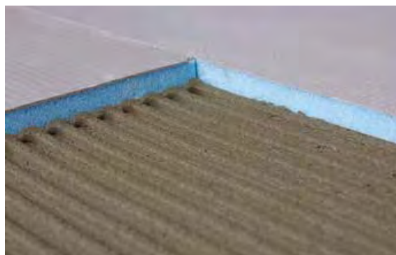
Skivorna lägges med en förskjutning.
