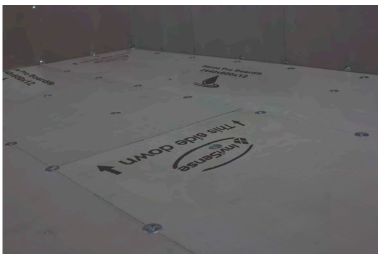
Fäst skivornas hörnor och centrum linjen med skruv och bricka.
