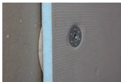
Monteringsbrickan får inte skapa en höjd eller för stor grop.
