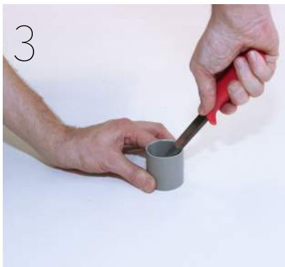
3 Clean the pipe. Rensa röret från ojämnheter.
