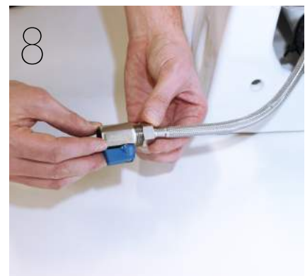
8 The very last step of the installation is connection the water. Test-flush the WC before first usage. Det allra sista steget i installationen är att ansluta vattnet. Test-spolta WCn innan förstaanvändning.
